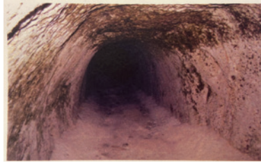
▲大本営海軍部壕内部の写真
